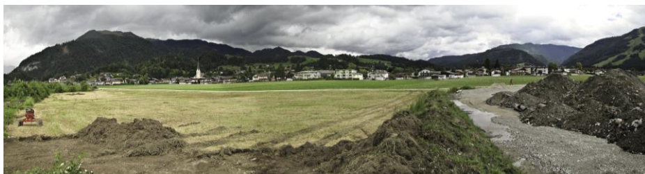
Abb. 2: Beginn der Abhumusierungsarbeiten (30. Juni 2014).
