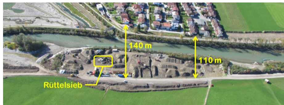
Abb. 8: Die Lage der Baustelle zur Erlausiedlung (14. Oktober 2014)
