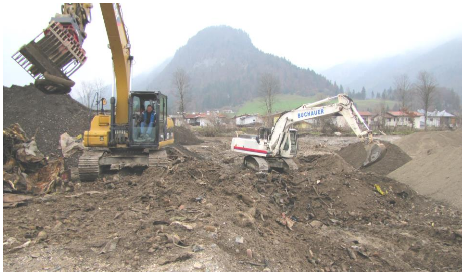
Abb. 15: Aussortieren von Grobteilen: Oben Schrott (Haufen rechts), unten: Der Bagger rechts sortiert Sperriges vor, der linke (mit Greifzange) klaubt KFZ-Reifen aus (10. Juni und 12. Nov. 2014)
