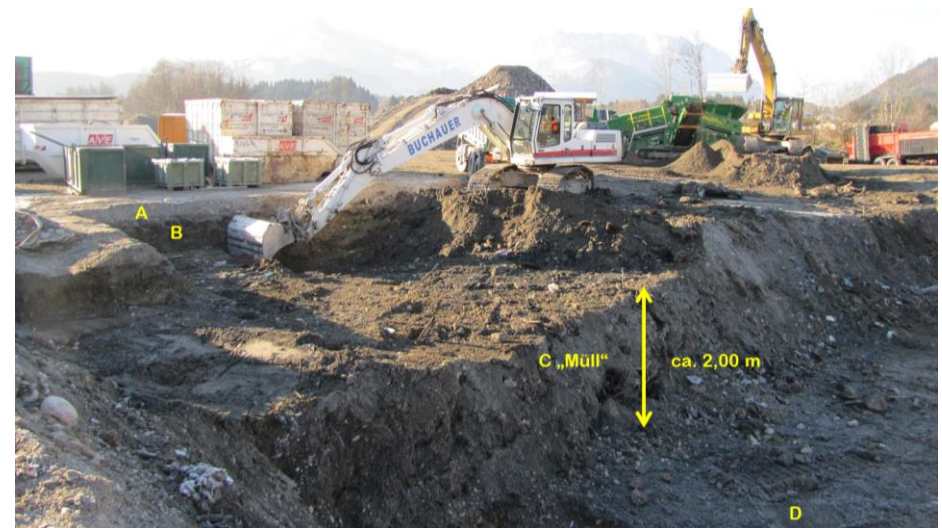
Abb. 12: Abtragen eines typischen vertikalen Schichtprofils A Schotter B unbelasteter Aushub C „Müll“ D Detritus (9. Dezember 2014)
