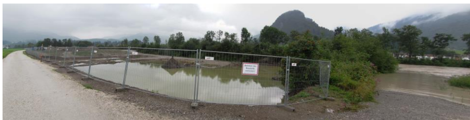
Abb. 48: Geflutete Baugrube 31. Juli 2015, am rechten Bildrand die Ache
