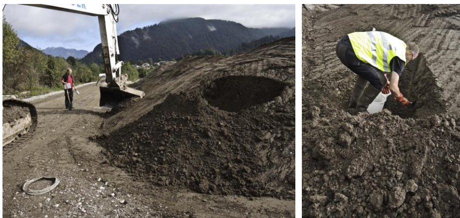
Abb. 7: Probenahme in Aushub < 40 mm durch Fachpersonal der CTUA
