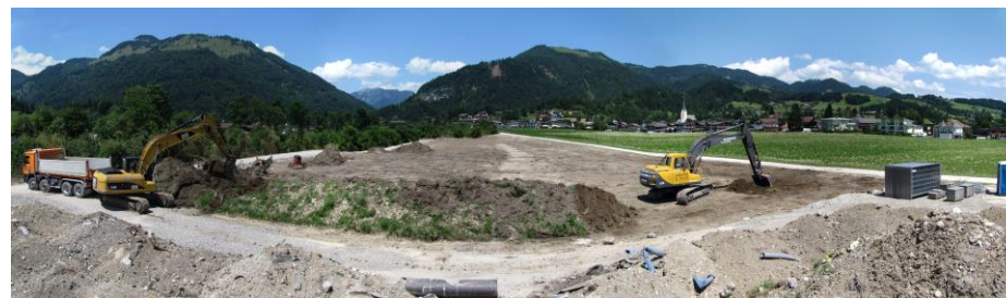
Abb. 4: Verladen des abgeschobenen Oberbodens vermischt mit Mähgut, rechts: angelieferter Bauzaun und Toilette (7. Juli 2014)
