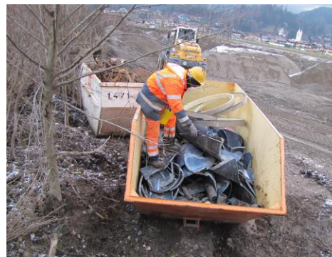
Abb. 41: Überdachte Sammelstelle für Sonderabfall-Kleinmengen (links), Stabilisierung von Asbestabfall vor der Abholung (rechts)
