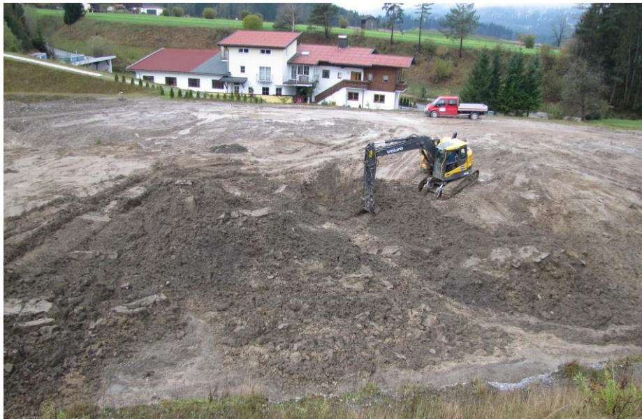
Abb. 9: Deponie Ritzer: Verräumen und Einbau aus der Auwirlslacke angelieferter strukturarmer, nasser Chargen (24. Oktober 2014)
