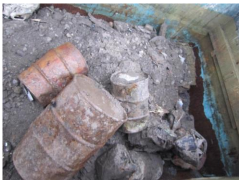
Abb. 40: Ölverunreinigtes Aushubmaterial mit teilweise gefüllten Fässern (links) gelagert in flüssigkeitsdichtem Container (rechts)
