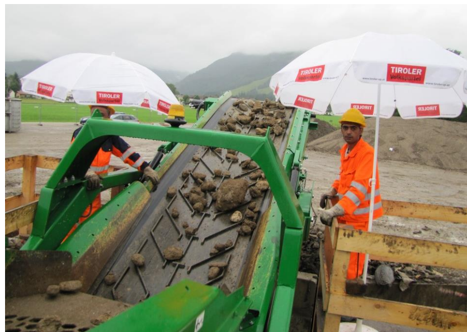
Abb. 6: Siebaustragsband > 70 mm mit Sortierpodesten und (vorerst !) provisorischem Wetterschutz (30. Juli 2014)
