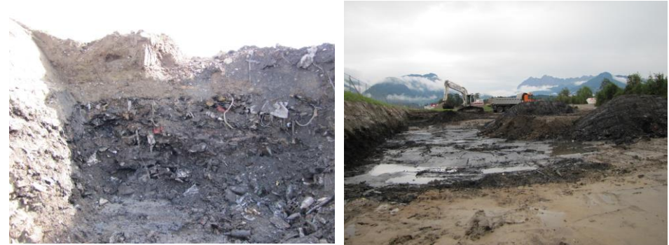
Abb. 13: Vertikales Schichtprofil (8. Sept. 2014) im Foto links, rechts geräumter Abschnitt mit dunkel gefärbtem Detritus und eintretendem Grundwasser an der Grubensohle (26. August 2014)
