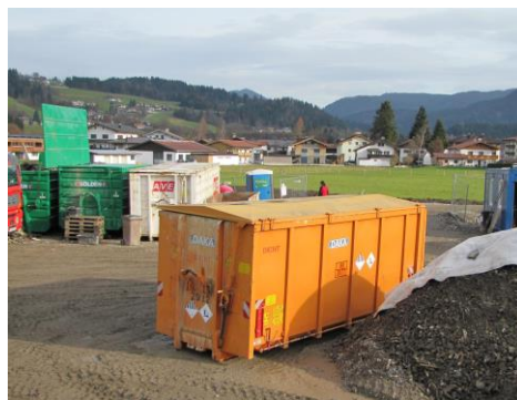
Abb. 40: Ölverunreinigtes Aushubmaterial mit teilweise gefüllten Fässern (links) gelagert in flüssigkeitsdichtem Container (rechts)
