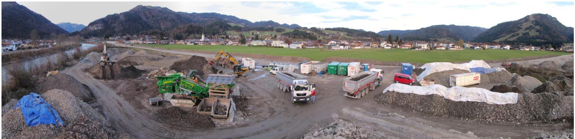
Abb. 29: Panoramablick (Darstellung daher verzerrt: Bildhintergrund von „Entenloch“ bis Unterberg): Links Aufbereitung, dahinter Mieten < 40 mm, rechts davon Container für Aussortiertes, Baustelleneinfahrt und Bürocontainer (blau), ganz rechts: Mittelkornlager (12. November 2014)
