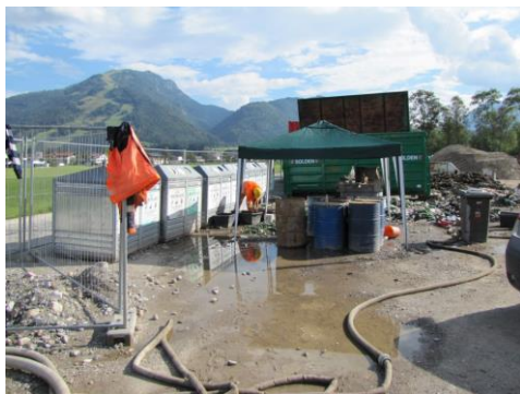
Abb. 41: Überdachte Sammelstelle für Sonderabfall-Kleinmengen (links), Stabilisierung von Asbestabfall vor der Abholung (rechts)
