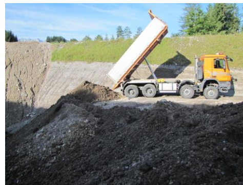
Abb. 43: Abladen von Bodenaushub der Qualität „Bodenaushub mit Hintergrundbelastung“ auf der Deponie Ritzer (links) bzw. der Qualität „Inertabfall“ auf der Deponie Hallbruck (rechts)
