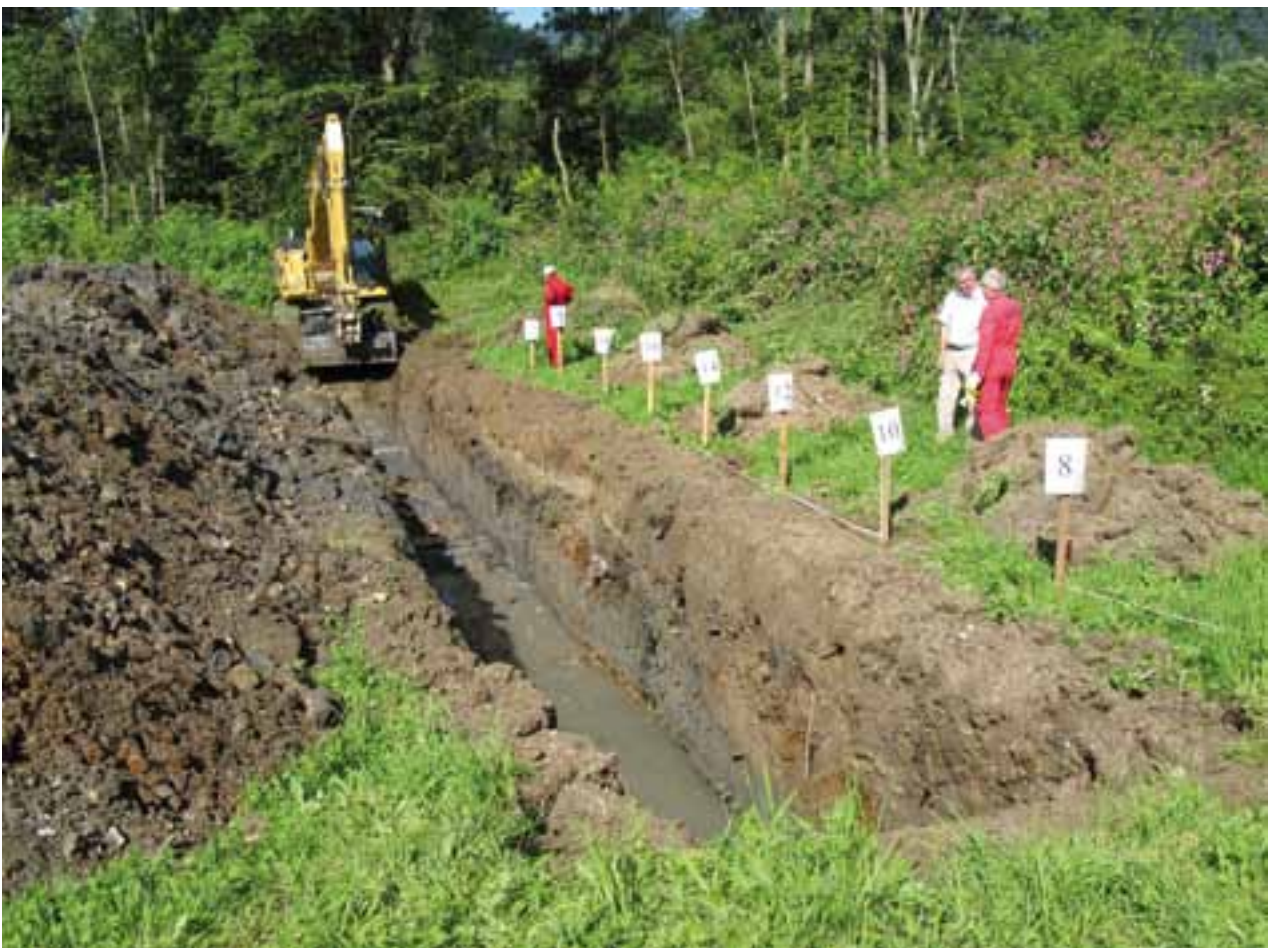
August 2008: der erste von 21 Baggerschürfen.
